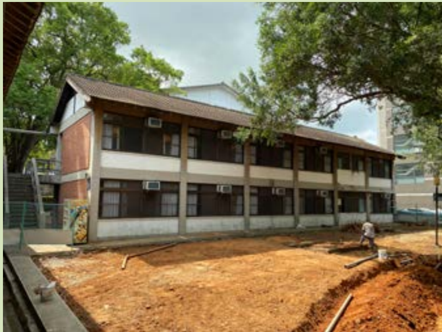
▶ 戶外景觀施工中
